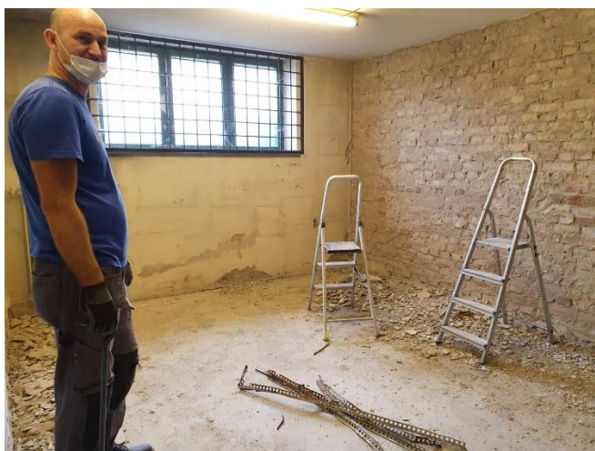
Bild från renoveringen
